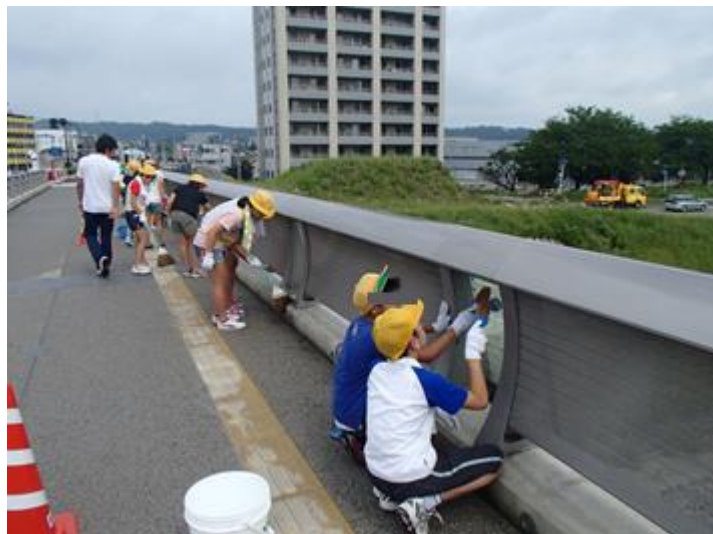
地元小学生による高欄清掃(平成24年度～継続中)
