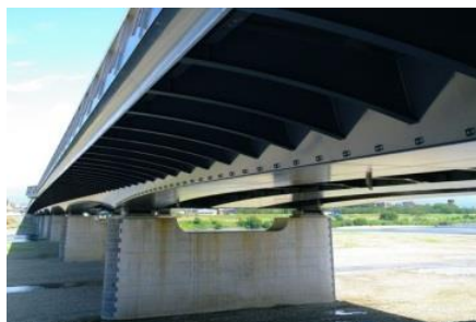
美しい2点支承の主桁と橋脚の納まり
