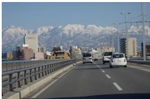
新富山大橋:センターポール形式の採用ですっきりした橋面
