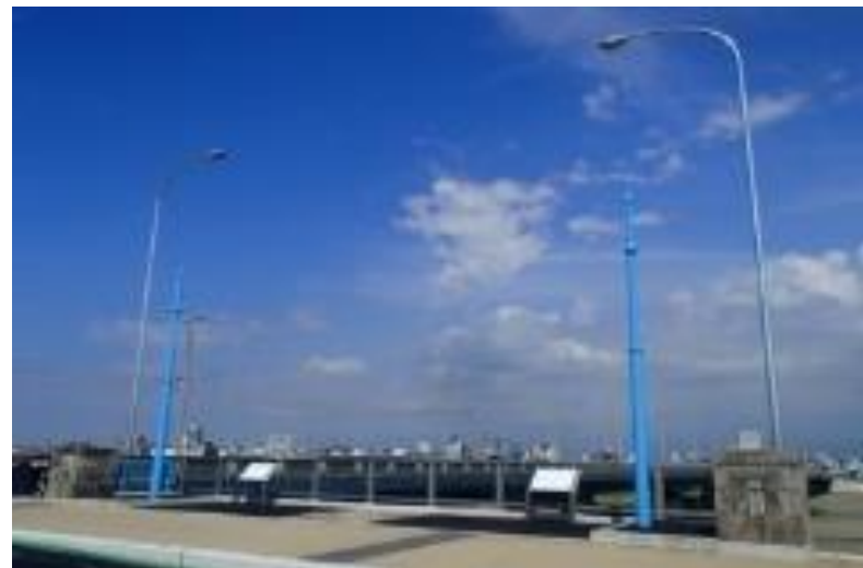
兩岸の橋梁端部を原位置に復元保存 (平成27年7月11日)
