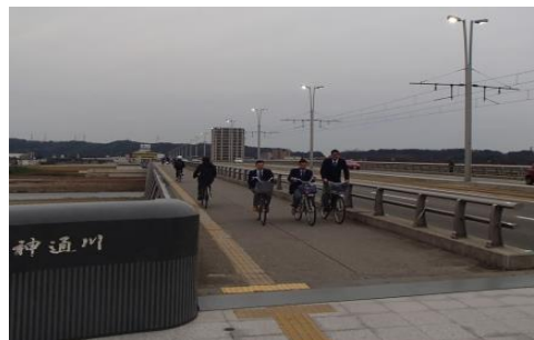
新富山大橋:歩道を4.5mに拡幅
