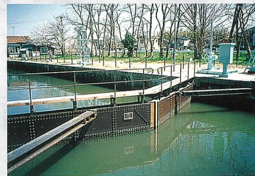
▲門扉(リベット接合と水密部の檜)
