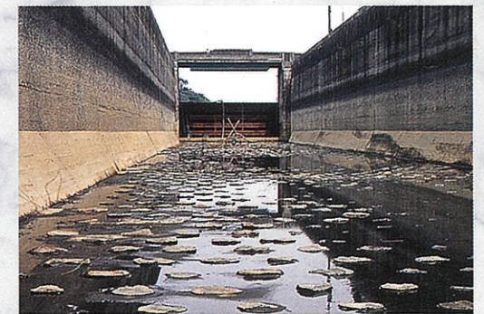
▲底部表面の千鳥配置の割石(閘室に入った船が竿を使い移動しやすいように引っかかりを設けている)
