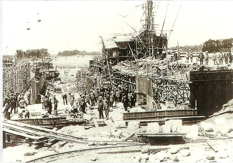
建設中の中島閘門
