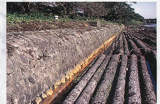
▲曲面護岸(上部の曲面がめずらしい)
