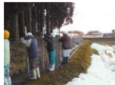
耐雪型侵入防止柵の設置
