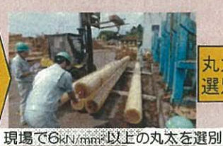
現場で6kN/mm 2 以上の丸太を選別
