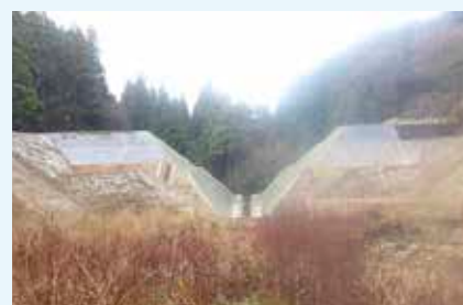
ため池の廃止 (窪野上池 黒部市)
