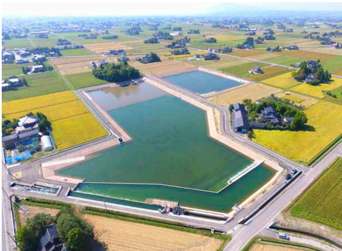
「山王川調整池（庄川左岸地区）」
