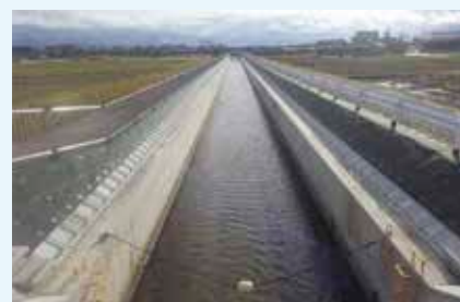
排水路整備後 (海尻川排水路 南砺市)
