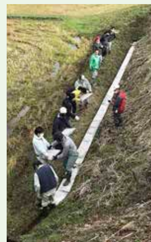
農村でのボランティア ＜水路の蓋掛け＞
