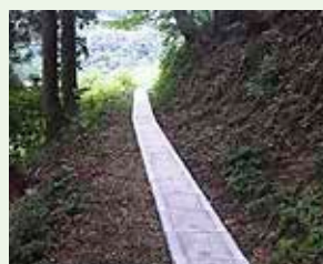
土砂流入を防ぐ蓋掛け整備
