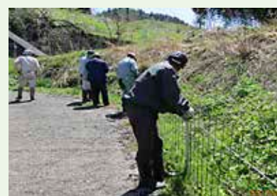
侵入防止柵の設置
