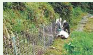
鳥獣対策の恒久柵設置 （小矢部市岩崎）
