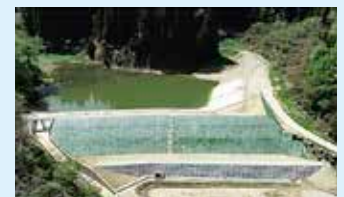
ため池の耐震化・老朽化対策 (氷見市 谷内山池)
