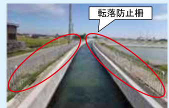
施設の長寿命化対策 (庄西 1 期地区 千保柳瀬水路)
