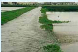
溢水被害状況 (庄川左岸地区 狐島用水路)
