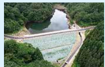
ため池の耐震化対策 (野地溜池)
