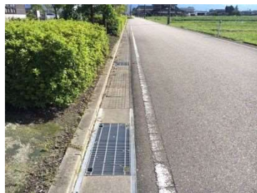
自由勾配側溝による暗渠化
