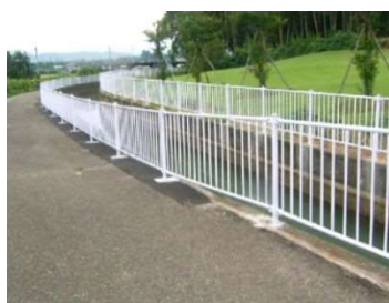
縦型防護柵(H=1.10m)
