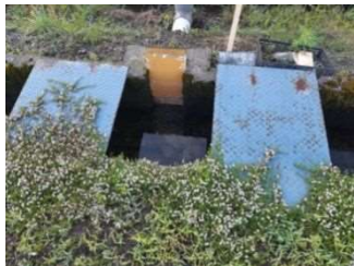
水管理時の足場確保のための水口蓋の設置 (コンクリート蓋、縞鋼板)
