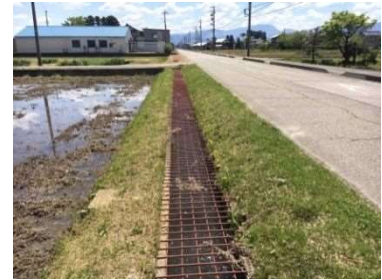
簡易な安全施設の設置
