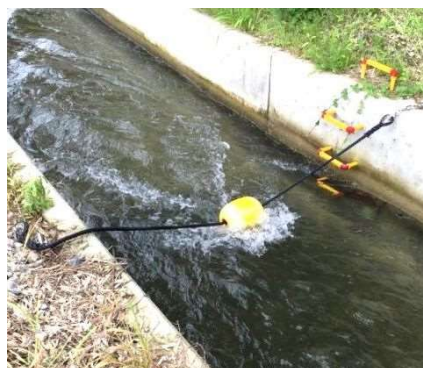
浮き、ロープ、タラップの設置
