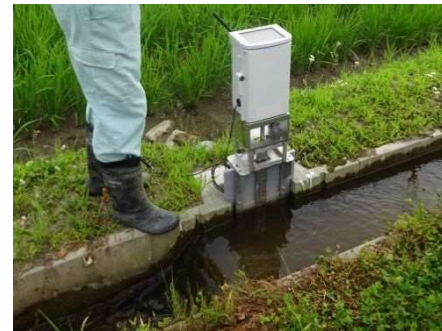
ICTによる水口水門操作
