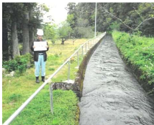
単管鋼管を用いた簡易柵
