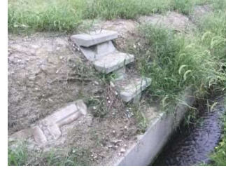
法面における階段の設置
