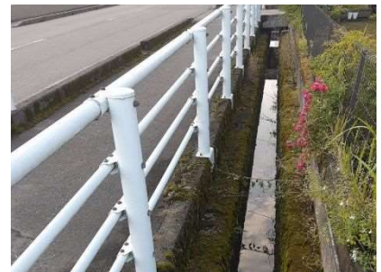
道路沿いの転落防止柵
