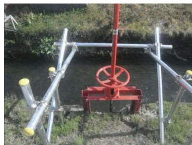
水門まわりの簡易安全柵の設置
