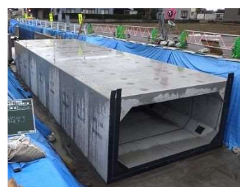
ボックスカルバートによる暗渠化
