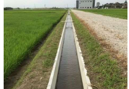
コンクリート水路
