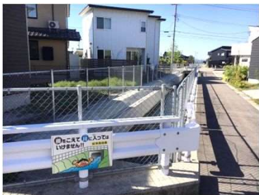
水路整備と併せて設置した事例①
