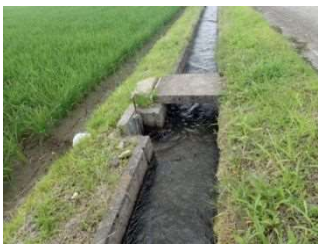
水管理時の足場確保のための水口蓋の設置 (コンクリート蓋、縞鋼板)
