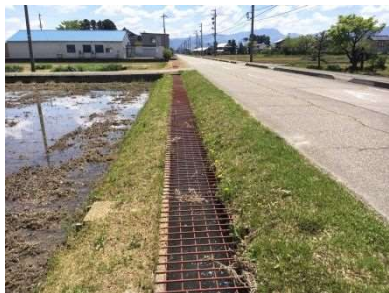
水路蓋(鉄筋網)
