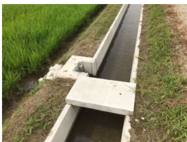
水口のコンクリート蓋の設置
