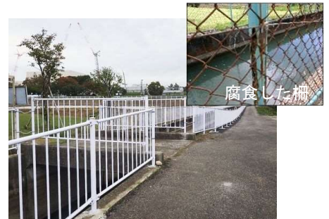
老朽化した柵の更新状況
