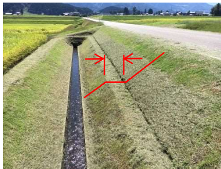
小段の設置による歩行・作業 スペースの確保
