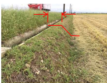
溝畔の復旧、整形による歩行・ 作業スペースの確保
