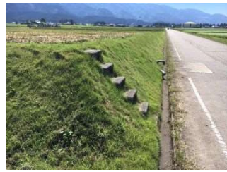
法面における階段の設置
