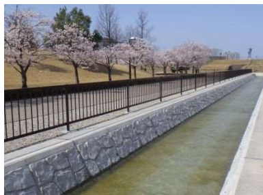
水路整備と併せて設置した事例②
