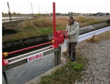
例6 水量調整のための水門操作作業
