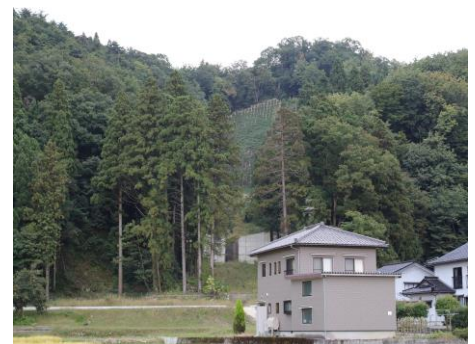
復旧工事状況：同左
