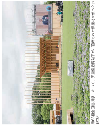
全国樹形祭では初めてとなる、柱や梁などの構造部材に県産材を使った木製テント
