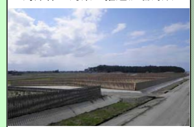
海岸保全対策の推進(入善海岸)
