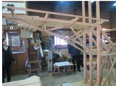
お野立て所基本ユニットの模型製作（実物の 1/3）
