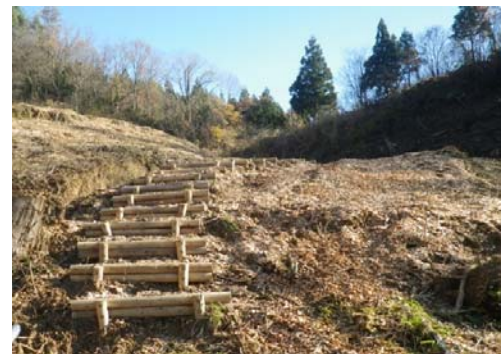
歩道や丸太階段の施工（黒部市田靱）
