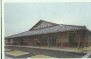
県産材を使った木造公共施設
