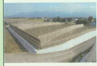
海岸保全対策の推進(入善海岸)
