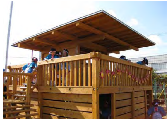
子どものデザインにもとづき木製遊具を幼稚園に設置しました。
