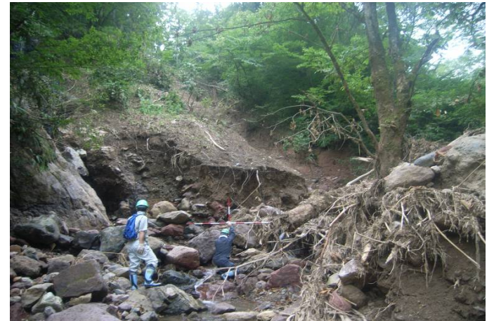
南砺市 樋瀬戸 峠野島 地内(猿倉谷:日中ダム下流左岸)
