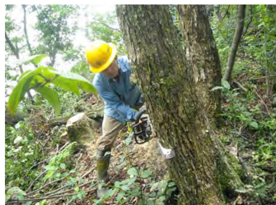
民家裏山にある枯損木を除去しました。
