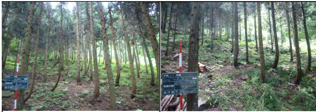
整備前の状況(二ヶ)
