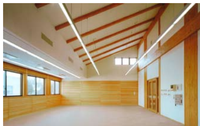
性能評価試験棟(内部)
