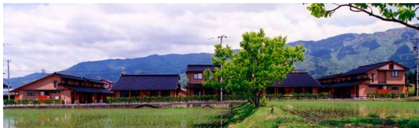
城端南部団地外観／写真上：玄関側より、写真下：背面より
