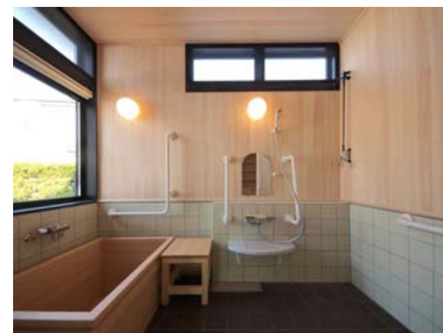
浴室、ヒノキの内装とサワラの浴槽、床は浴室用コルク
