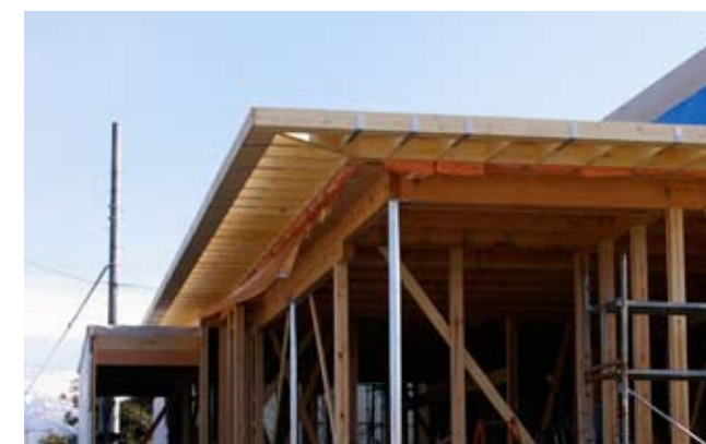
建築中の写真(正面底部)
