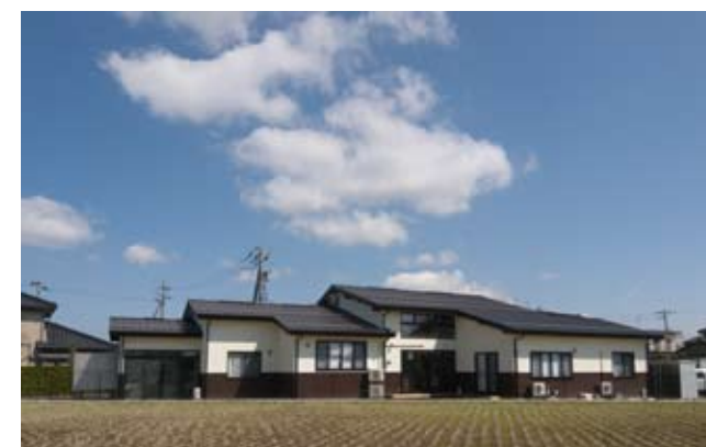
南側外観、腰板は県産スギ
