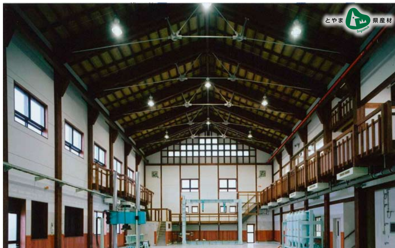
木質構造試験棟(内部)
