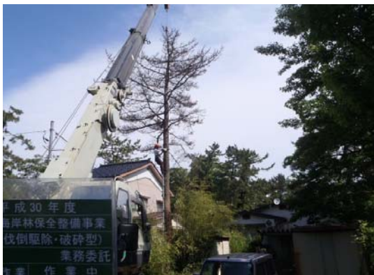
被害対策重点区域内での伐倒駆除 （富山市浜黒崎地区）
