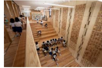
魚津市立星の杜小学校 (R2.1月竣工(H31.4月開校)) 全国初の木造3階建て小学校 事業主体：魚津市 延べ床面積：4,950m 2 県産材使用量：1,296m 3
