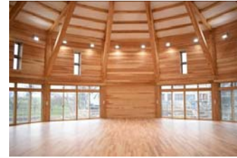
富山県立大学新学生会館 (H31.3月竣工) 県内初のCLT建築 事業主体：富山県 延べ床面積：860m 2 県産材使用量：205m 3
