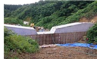
治山ダム工における残存型枠
