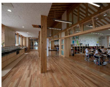
施設内部（普通教室と廊下） （燃えしろ設計による独立柱や小屋組）
