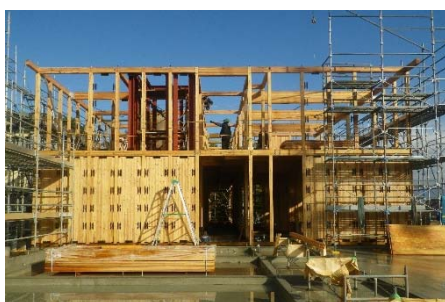
CLT 設置状況
