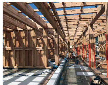
軸組み工法による構造躯体
