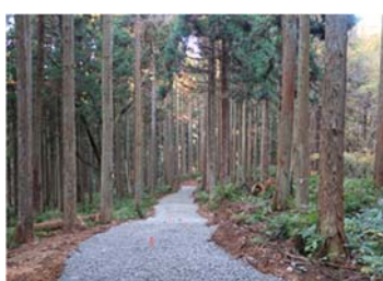
森林作業道の整備
