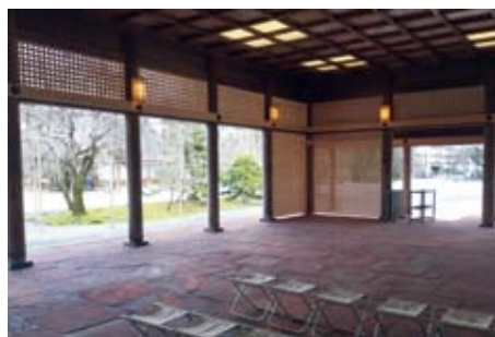
面格子で耐震化された拝殿（富山県護国神社）
