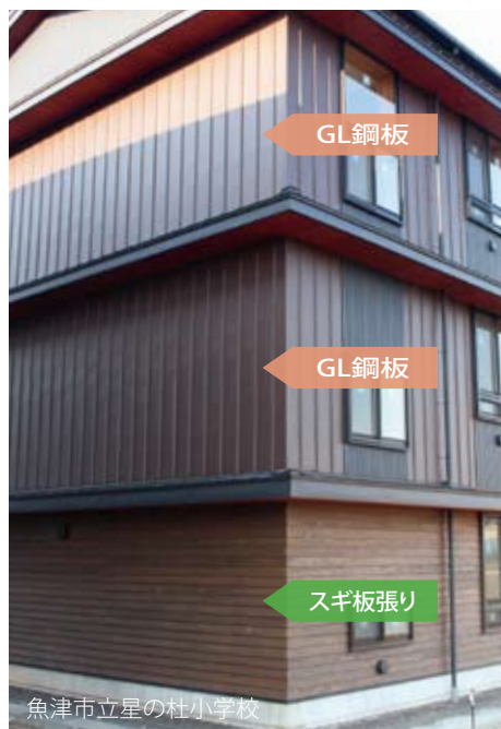
更新しやすい1階部分にスギ材を使用
