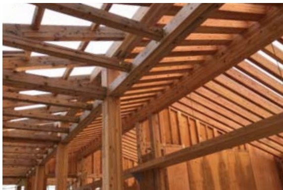
普通教室棟3階 小屋組トラス架構
