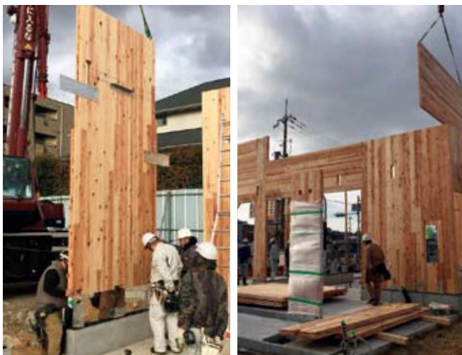
CLTパネル工法による建築工事
