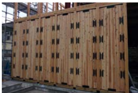
富山県木材研究所が開発したパネル型制震耐力壁
