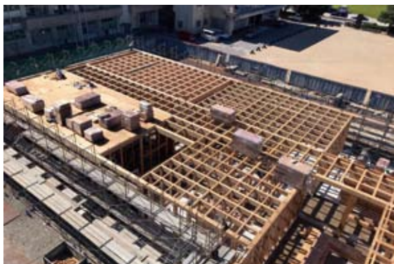
1階部分の梁桁を上空より
