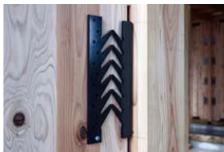
制震耐力壁に用いられる鋼製ダンパー
