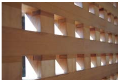
県産ヒノキ圧縮材を用いた耐震面格子
