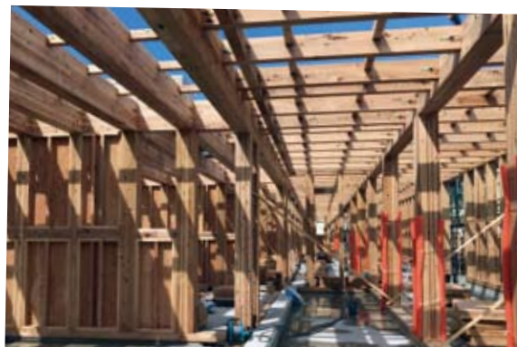
木造軸組工法による構造体(内部より)
