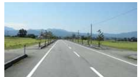
【砺波南部広域農道】 (南砺市)
