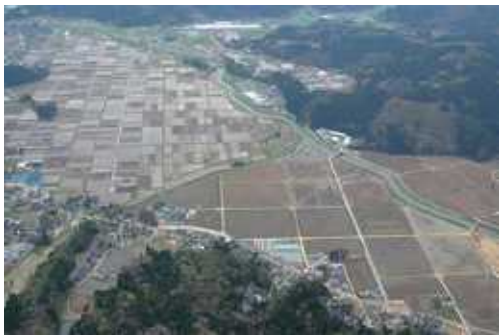
【大区画化整備されたほ場】（氷見市）
