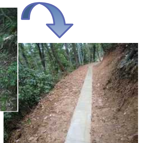
【土砂侵食崩壊防止のため蓋掛け整備された用水路 (富山市)】
