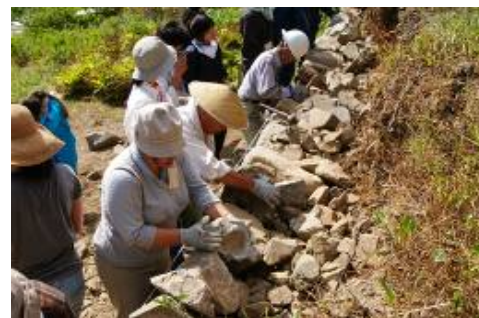
大学生との共同作業による石積み復旧
