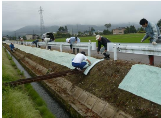
用排水路法面にセンチピードグラス植栽
