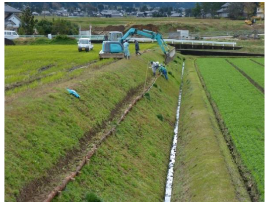
法面への小段の設置
