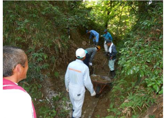
用水路の泥上げ作業
