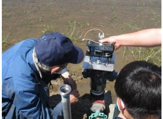
自動給水栓の設置工事
