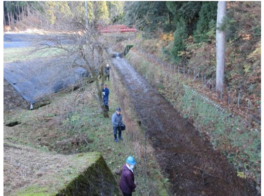
電気柵の撤去作業
