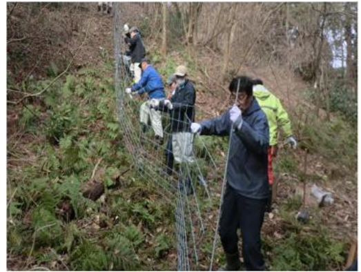
恒久柵の設置
