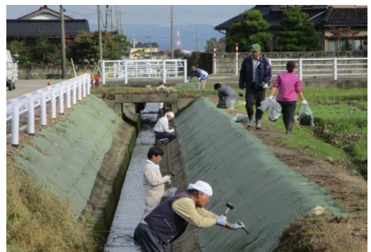
水路法面への防草シート設置
