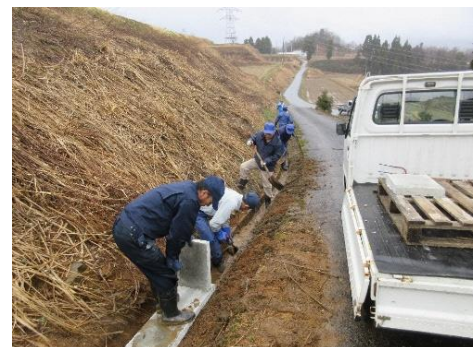
イノシシによる法面土砂崩落 対策の水路盖板設置
