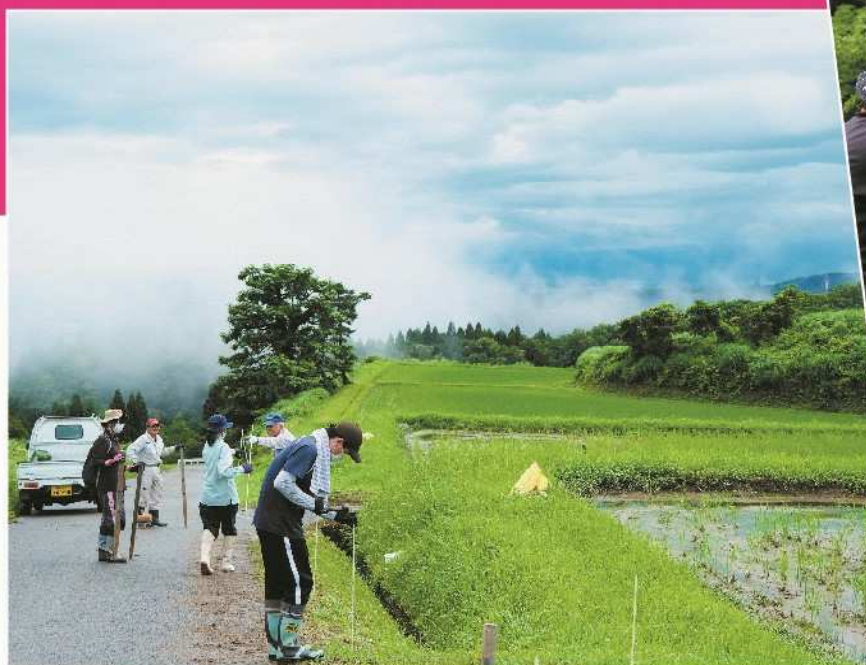
鳥獣が田畑に侵入しないようするための電気柵設置作業(富山市小羽)
