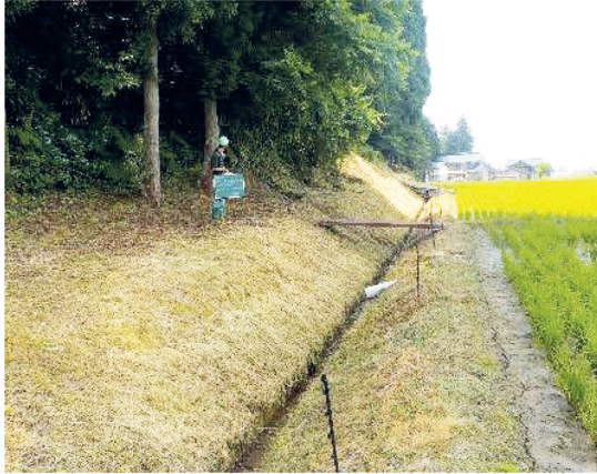
魚津市石垣地区の緩衝帯整備 (鳥獣被害防止総合対策事業活用)
