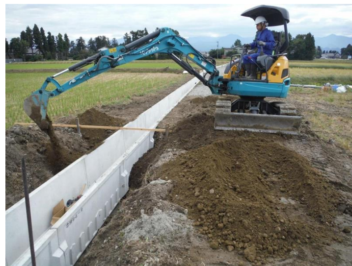
自主施工による水路改修
