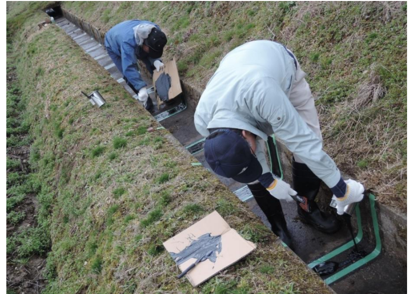
水路の目地補修
