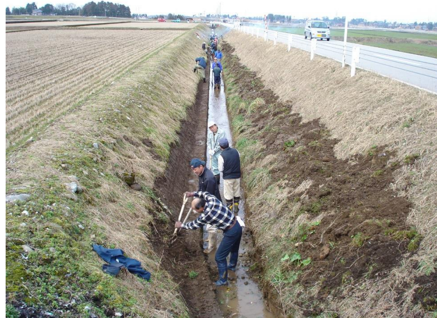
水路の泥上げ
