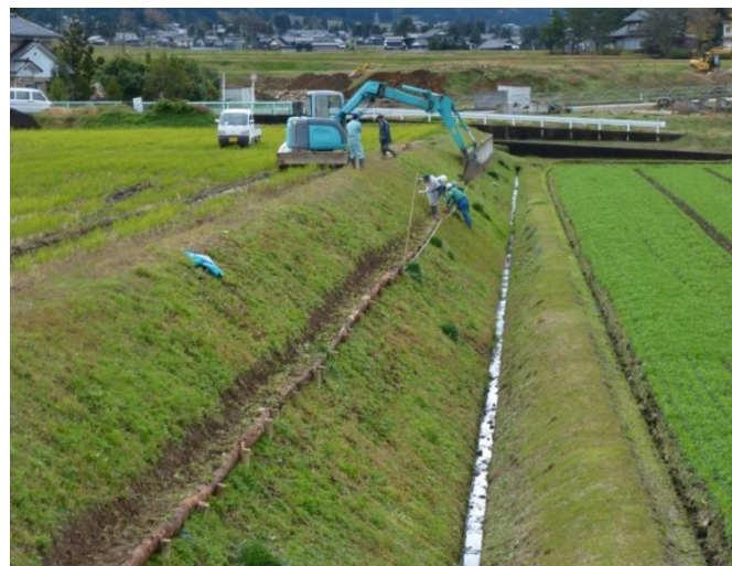
自主施工による法面小段の設置
