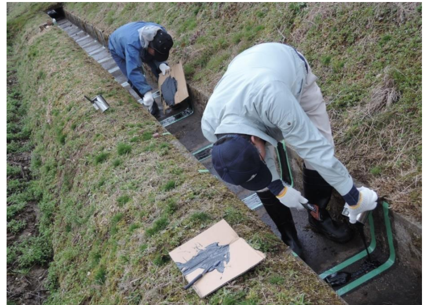
水路の目地補修
