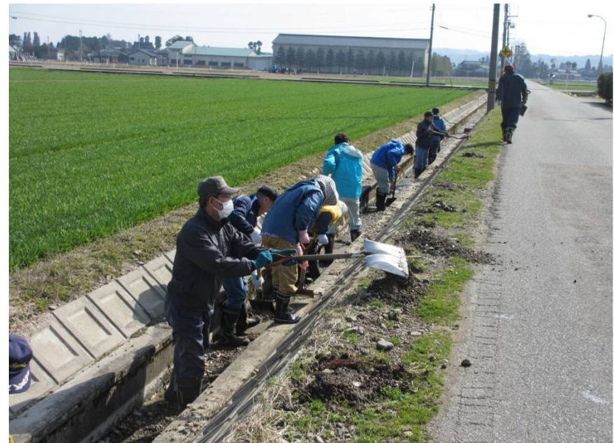
水路の泥上げ
