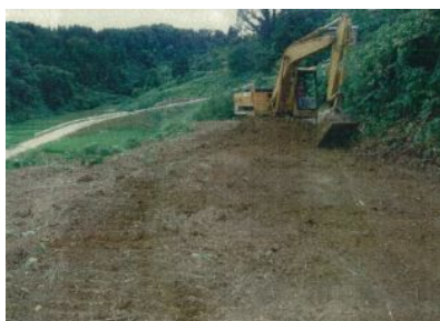
再生作業及び進入路整備
