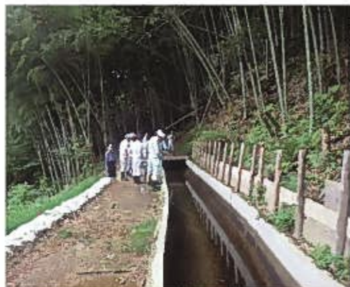
▲適切に維持管理を行うため水路の状態を確認
