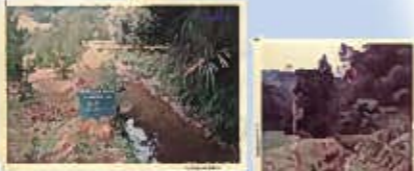
▲開設当時の戸久用水(昭和40年代工事の竣工前より)当時の苦労がうかがわれる
