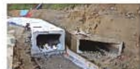
▲災害を未然に防ぐため古くなった用水路を改修
