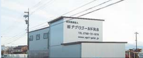
国道8号に隣接し本店にある乾燥調製施設
