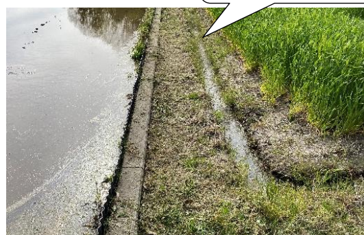
写真1 隣接田から漏水しているほ場
