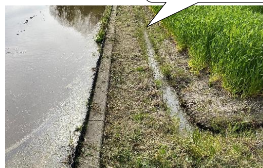
写真1 隣接田から漏水しているほ場
