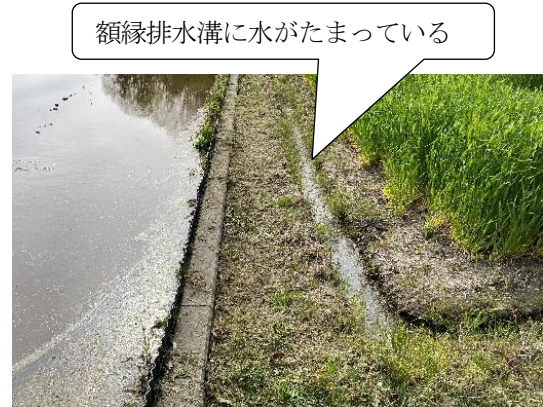
図5 隣接田から漏水しているほ場
