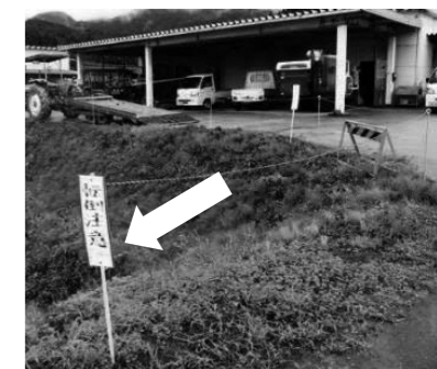
(例) 転落の危険性を警告する看板設置
