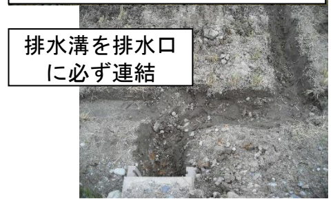
秋の収穫後、速やかに排水溝を設置
