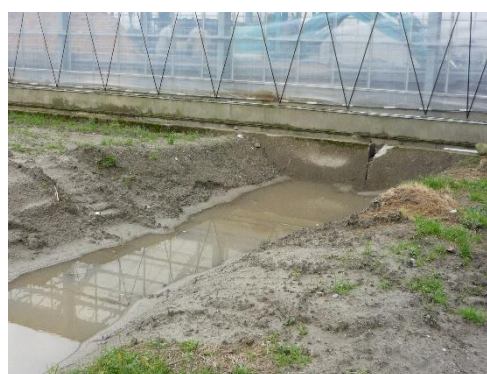
洗浄水の貯留池
