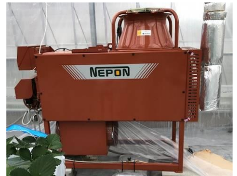
図2 燃油式暖房機(ボイラー)
