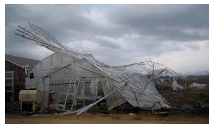
写真1 強風で倒壊したハウス
