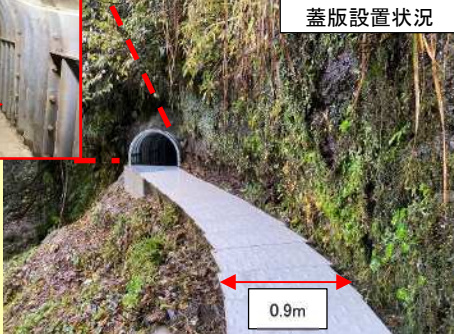
蓋版設置状況
