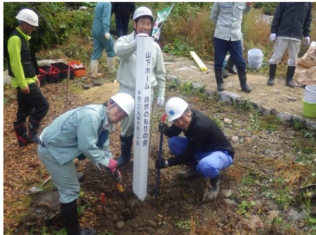
標柱も人力で設置しています。
