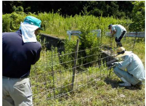
鳥獣害防止のための侵入防止柵設置 (P 6 に本文)
