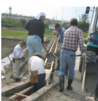
用水路の補修
