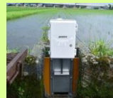
ICT自動給水栓等の設置
