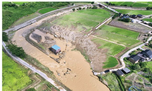
令和5年6月豪雨 2級河川白岩川(富山県立山町)
