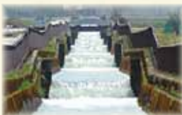
落差を有する農業用水路
